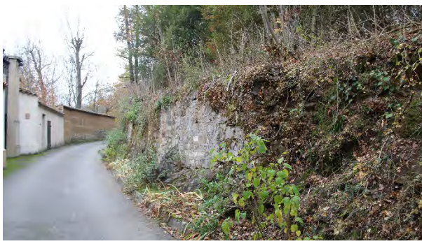
Restauration des murs de soutènement
