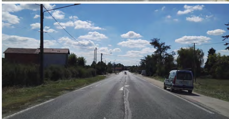
La RD 307, axe central et traversant le site classé est jalonnée de réseaux aériens
