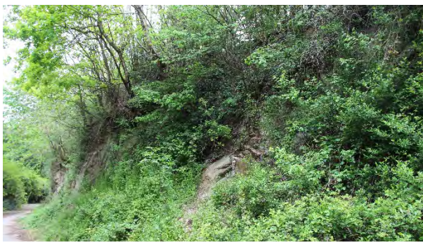
Risque d'effondrement d'un talus
