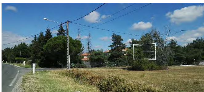
Les réseaux aériens et la signalétique
