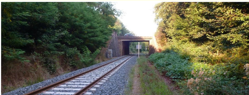
Passage supérieur de la RN6 sur la voie ferrée
